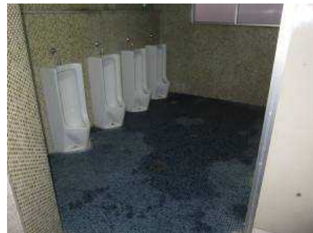
トイレの老朽化による臭気の発生
