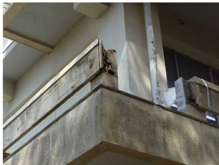
老朽化による手すりの落下
