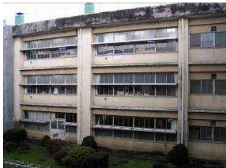
外装材の著しい劣化
