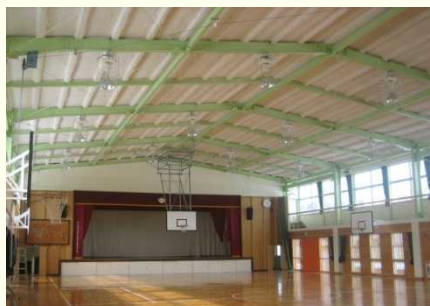
ノンフロン湿式不燃断熱材を吹付 (現場発泡ウレタン下地)
