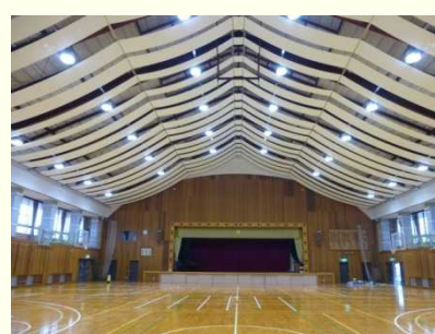
(軽量の)膜天井を設置
