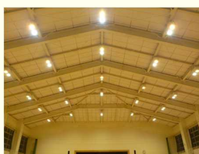
母屋への下地直接取付による 既存グラスウールボードの再設置
