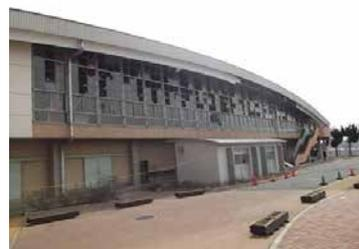
大開口部のはめ殺し窓※の破損。硬化性パテ※の使用により変形に追従できず破損。
