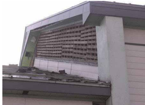
外装材の損傷
