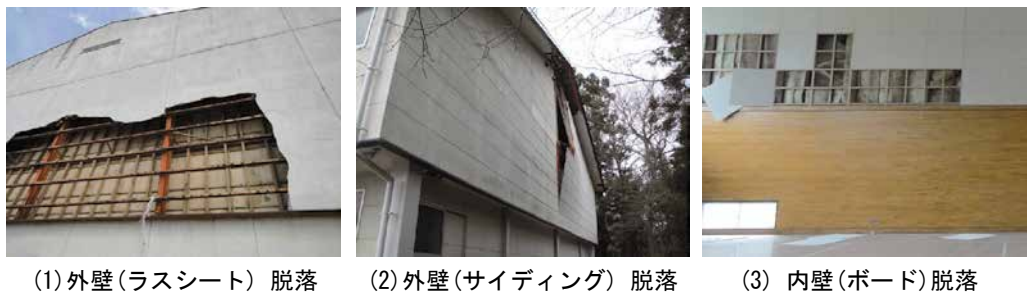
写真6 外壁・内壁の脱落被害の例
