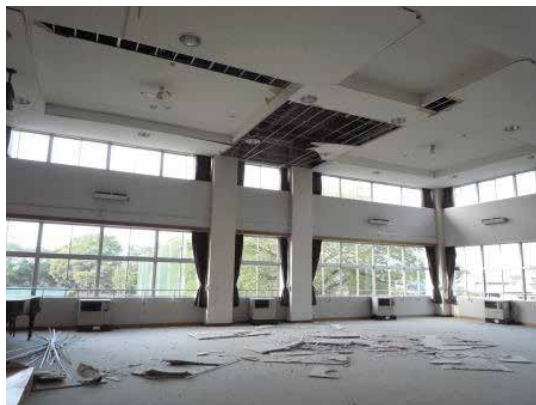
写真12 階高の高い大空間の天井の脱落
