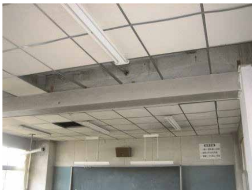
写真14 システム天井の脱落（普通教室）
