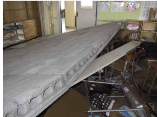
写真25 RC造架構との境界部分
