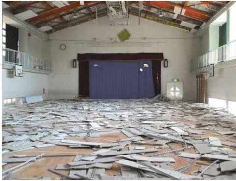
天井材の脱落
