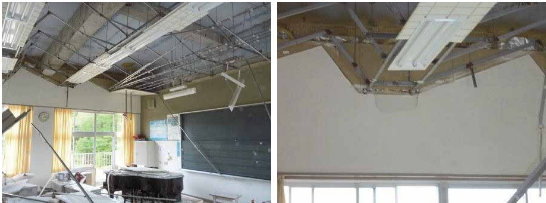
写真13 折れ曲がり天井の脱落
