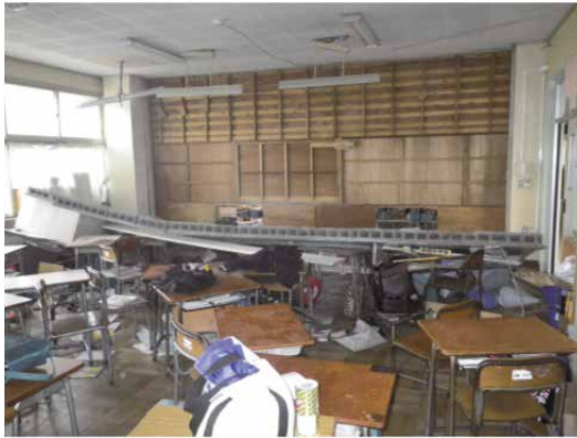
写真24 コンクリートブロック壁の全面倒壊
