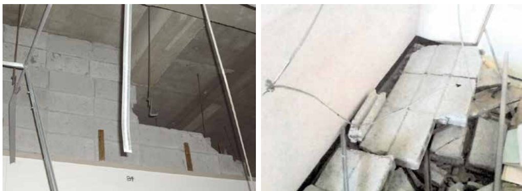
写真 7 コンクリートブロック壁の一部脱落
