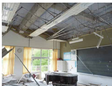
(2) 音楽室の折れ曲がり天井脱落
