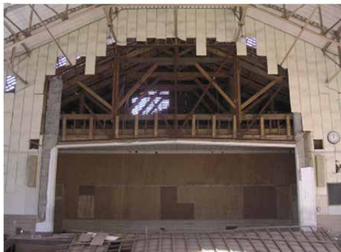
ステージ前部の壁の脱落
