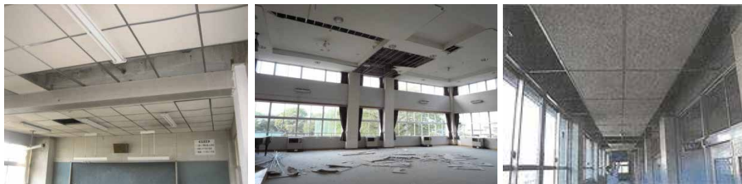
(1) 普通教室の天井脱落
