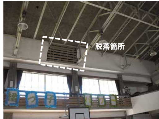
写真 11 内壁（ラスモルタル）の脱落
