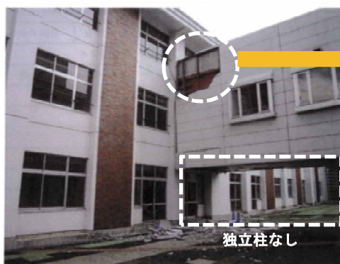
写真19 外装材(押出成形セメント板)の脱落
