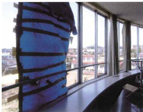
写真17 横連窓の障子ごとの脱落 (4階音楽室)
