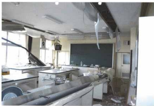
写真 16 天井裏の暖房設備の脱落
