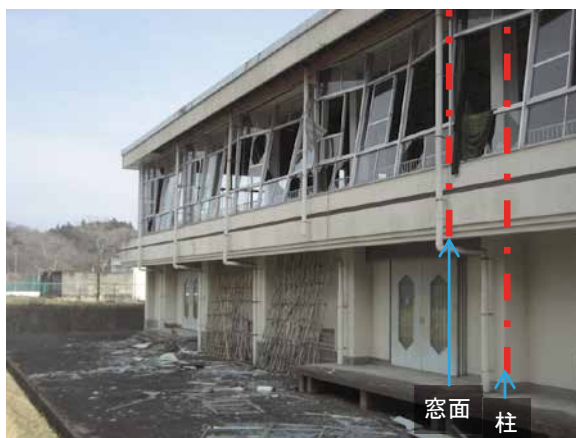
写真 8 桁行面の窓と柱の関係(例)
