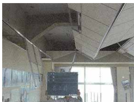
(1) 音楽室の折れ曲がり天井脱落
