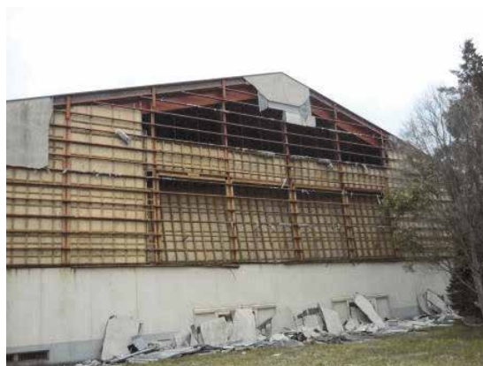
写真 9 外壁妻壁のラスシートの全面脱落
