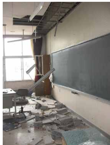
(参考) 写真27 教室間のブロック壁が天井裏から落下した事例
