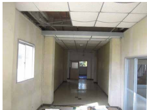
写真15 Tバーの破損・変形（廊下）
