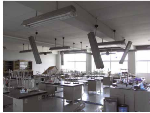
照明器具の脱落
