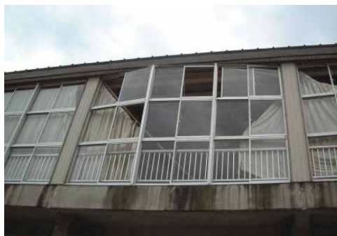
窓ガラスの破損
