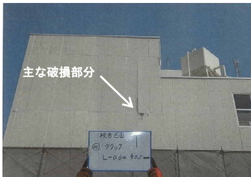
写真 21 外装材 (ALC パネル) の損傷
