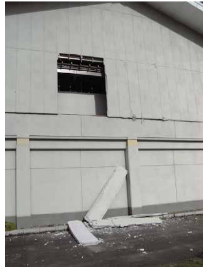
(参考) 写真 22 過去の震災における ALC パネルの脱落被害
