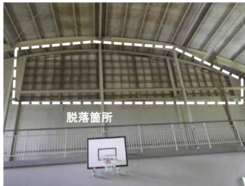
写真 10 内壁（有孔ベニヤ板）の脱落
