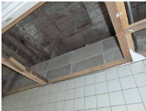
(参考) 写真26 頂部にアンカーがなく ブロック壁が落下した事例
