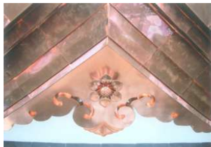
銅板張り唐破風(金沢城河北門)
