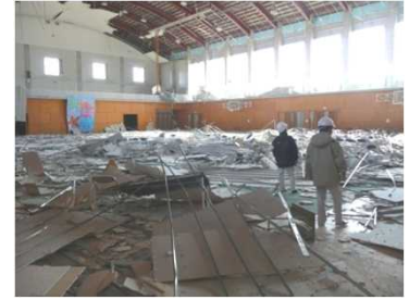
地震により天井材が落下した体育館 (宮城県栗原市)
