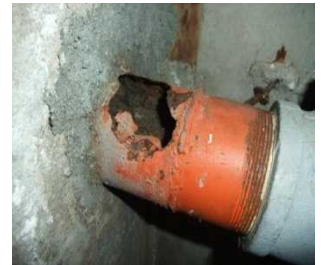
劣化による配管の破損
