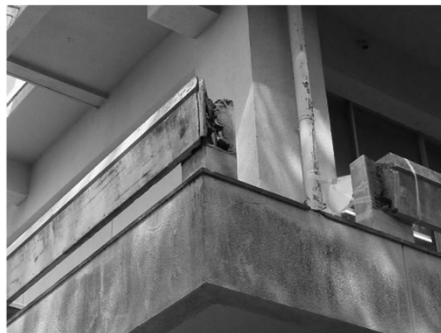
老朽化による手すりの落下
