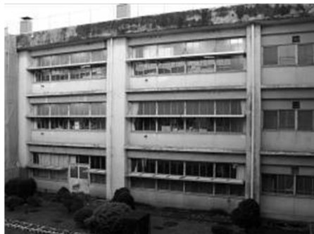
外装材の著しい劣化
