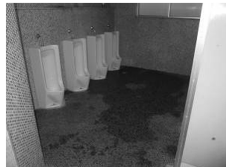
トイレの老朽化による臭気の発生
