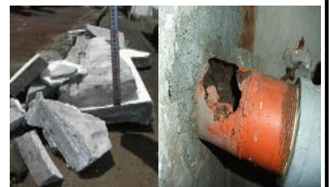
(左)落下したモルタル (右)劣化による配管破損
