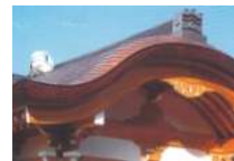
専念寺唐破風銅板工事
