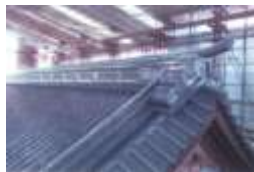
金沢城復元工事(河北門屋根工事)
