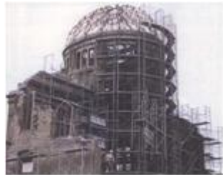
原爆ドーム改修工事
