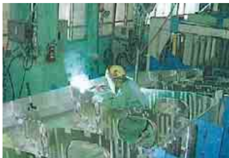
アルミニウム合金構造物のMIG半自動溶接作業
