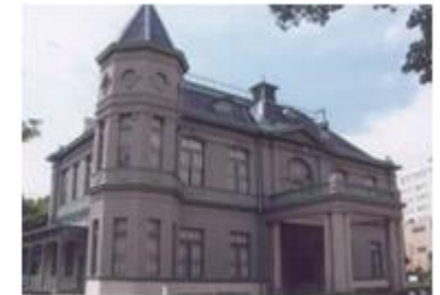
旧福岡県公会堂貴賓館(重要文化財)震災復旧
