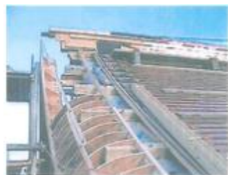
成田山川越別院改修工事(屋根部分)
