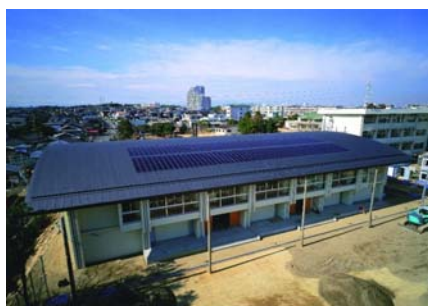
体育館屋根に設置
