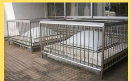
周囲に防護柵が設置された天窓
