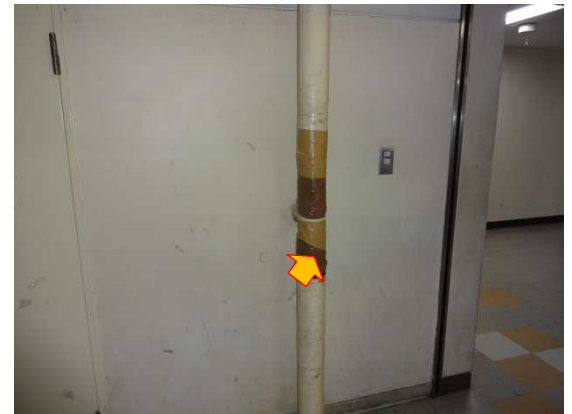
写真④（応急処置の状況）
