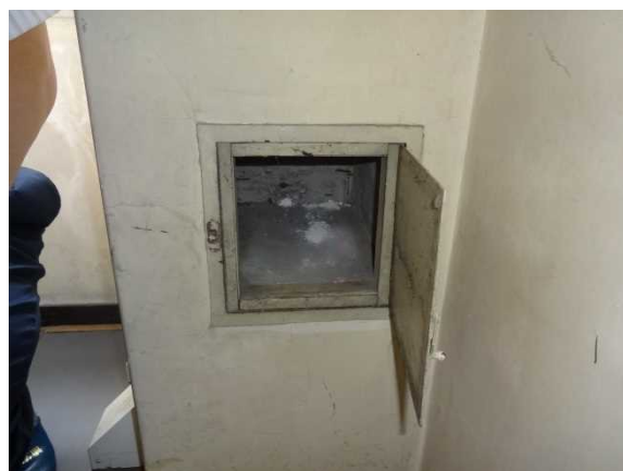
写真⑦（石綿セメント円筒）
