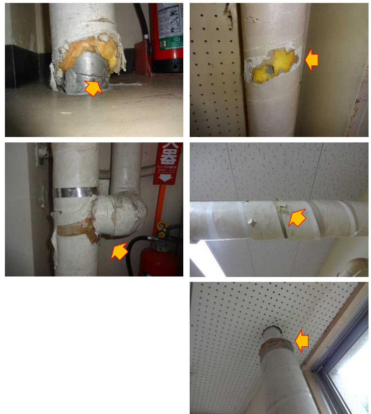
写真②（劣化・損傷の状況）
