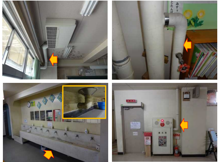
写真①（露出配管の状況）
