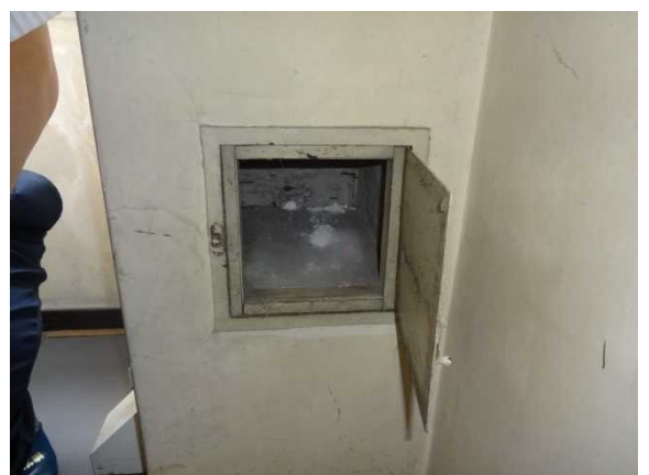
写真⑦（石綿セメント円筒）
