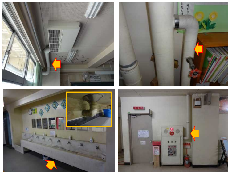
写真①（露出配管の状況）
