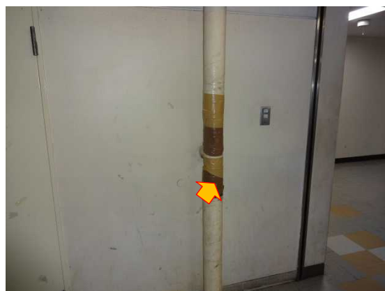
写真⑥（応急処置の状況）
