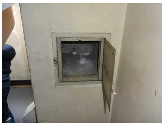
写真⑦（石綿セメント円筒）
