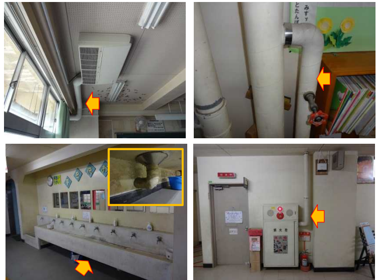
写真①（露出配管の状況）
