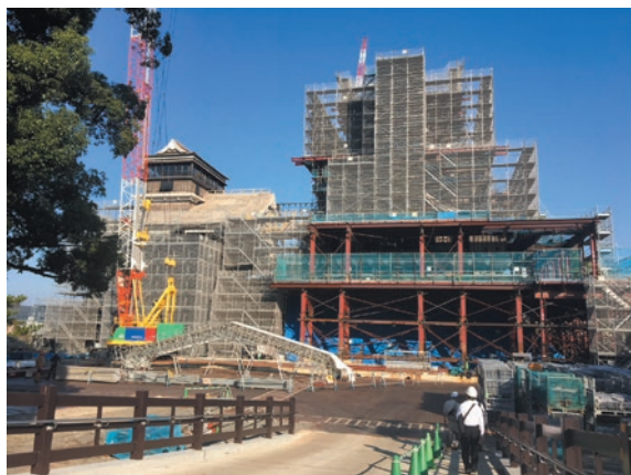
平成28年（2016年）熊本地震により 被災した熊本城の復旧工事
