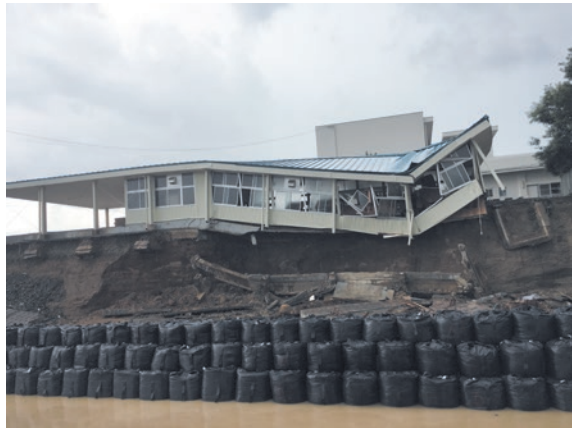
九州北部豪雨により被災した学校施設 (隣接する河川の洗掘により被災)
