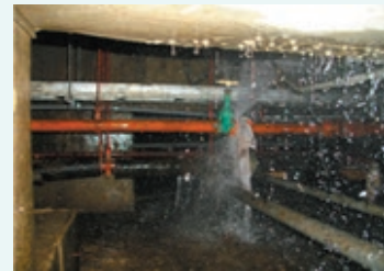
配管からの漏水
