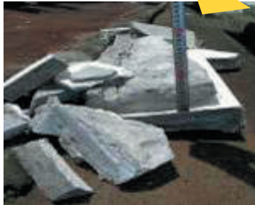
老朽化によりモルタルが落下
