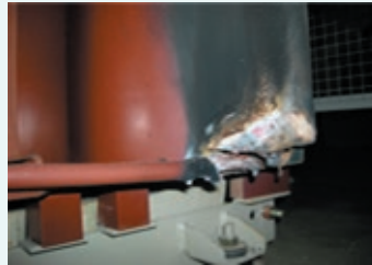
変圧器の発火による損傷
