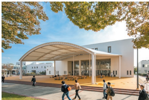
老朽化した図書館の改修
