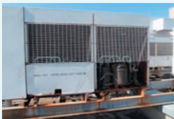
空調機の内部劣化
