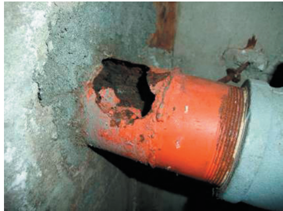
劣化による配管破損
