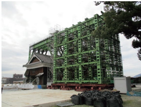
熊本城 飯丸丸五階櫓の応急支持工事
