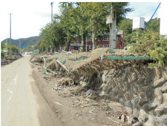
被災した学校施設（土砂流入によるフェンス破損・地震による窓枠の破損）
