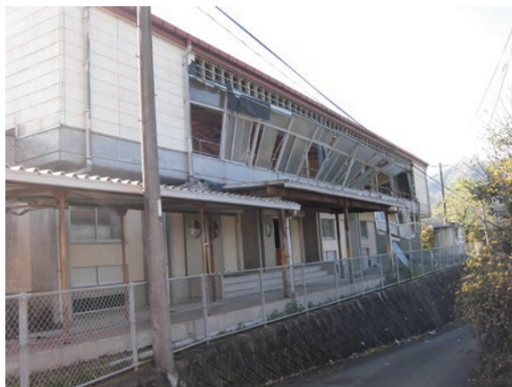
被災した学校施設（土砂流入によるフェンス破損・地震による窓枠の破損）
