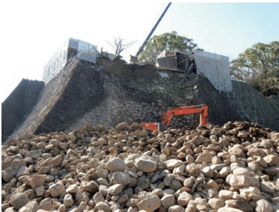
熊本城 重要文化財北十八間櫓の復旧工事
