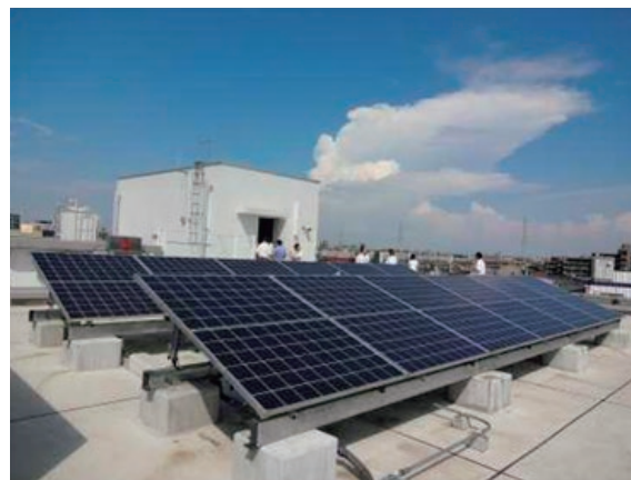
停電時に使用可能な太陽光発電システム (「災害に強い学校施設の在り方について」(平成26年3月)より)
