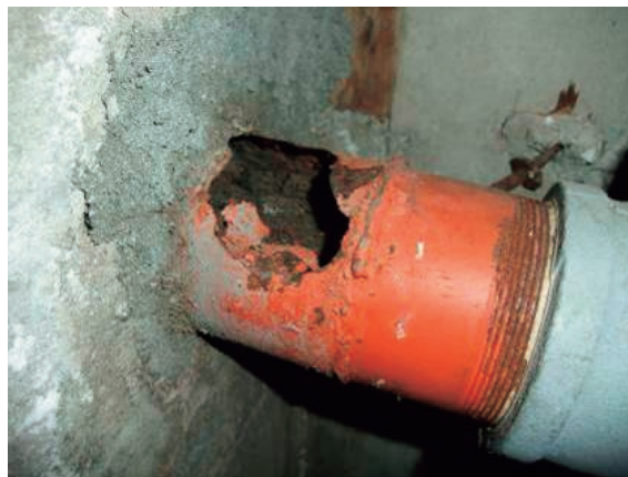
劣化による配管破損
