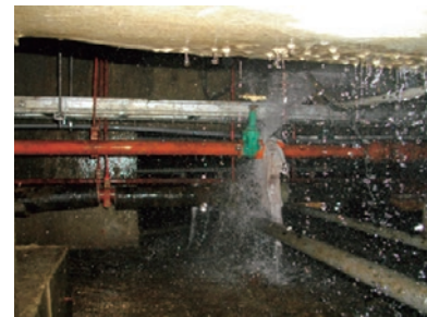
配管からの漏水
