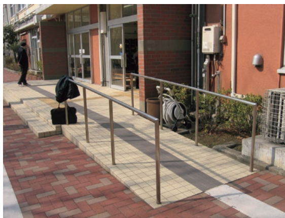
校舎出入口のスロープ(東京都世田谷区立三宿中学校) 「学校施設のバリアフリー化整備計画策定に関する実践事例集」より
