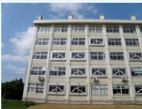
学校施設の耐震化対策 (新潟県立安塚高等学校) 「公立学校施設整備に関する 防災対策事業活用事例集」より
