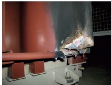
変圧器の発火による損傷
