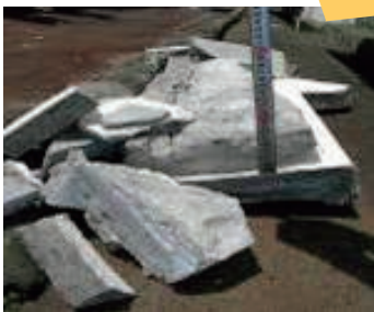
老朽化によりモルタルが落下
