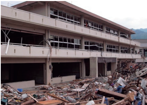
津波により被害を受けた校舎
