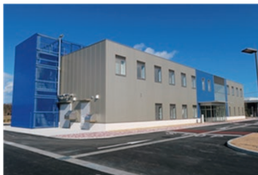
廃炉国際共同研究センター 国際共同研究棟
