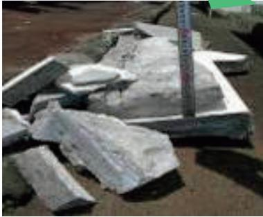
老朽化によりモルタルが落下
