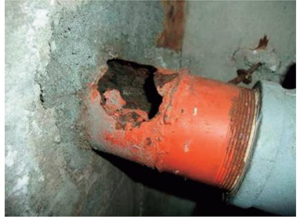
劣化による配管破損
