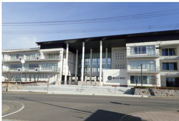
平成27年度に改築が完了した校舎
