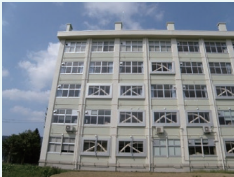
学校施設の耐震化対策 (新潟県立安塚高等学校「公立学校施設整備に関する防災対策事業活用事例集」より)
