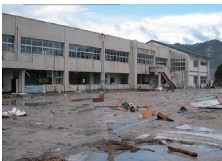
津波により被害を受けた校舎
