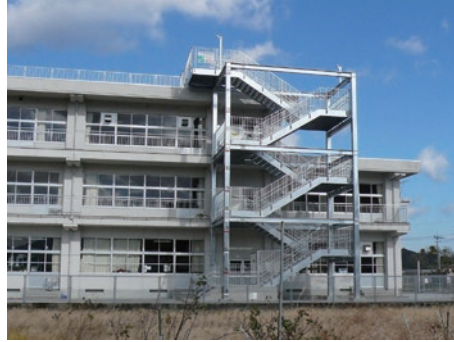
屋上への避難階段
