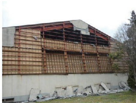
外壁が全面脱落した被害の例
