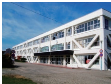
耐震化工事により補強された校舎
