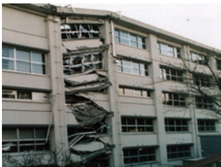
地震により倒壊した校舎
