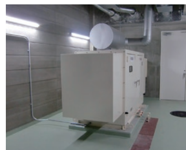
自家発電設備
