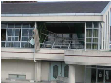
窓枠ごと脱落した被害の例
