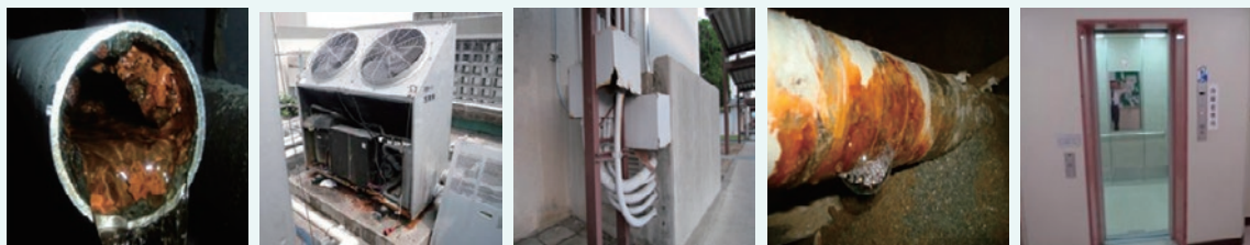
図表 1-2-24 ライフラインの老朽化 (断水, 空調停止, 停電, ガス停止, エレベーター停止)
