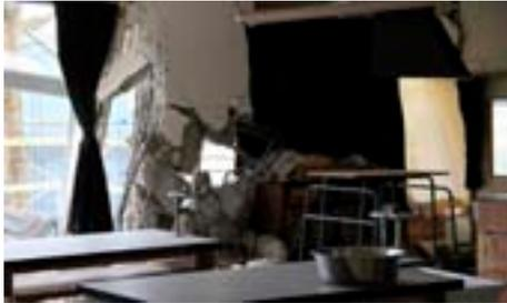
地震により崩壊した教室の柱（福島県本宮市）
