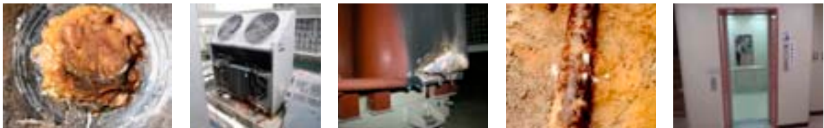
ライフラインの老朽化（断水、空調停止、停電、ガス停止、エレベーター停止） ※特に大学の建物の内・外部には多くのライフラインが設置されている。
