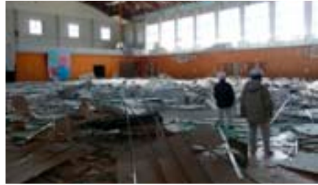
東日本大震災により天井が全面的に落下した屋内運動場
