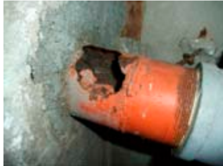
劣化による配管の破損
