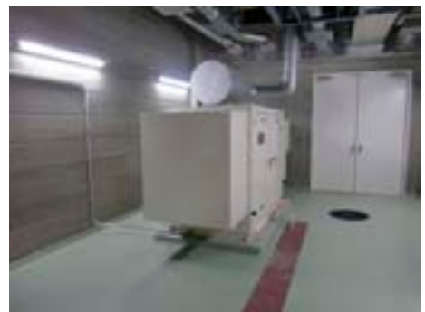
自家発電設備
