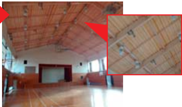
天井撤去後の状況（屋根面にウレタン材を塗布）
