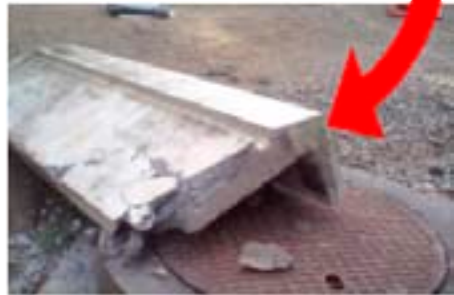
老朽化による手すりの落下
