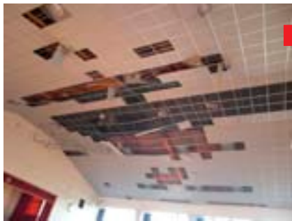
中央部分をはじめ天井が広範囲に落下
