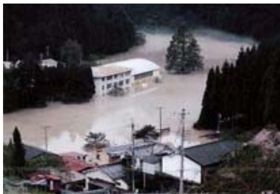
平成23年の台風第12号で被災した学校被害(学校浸水)
