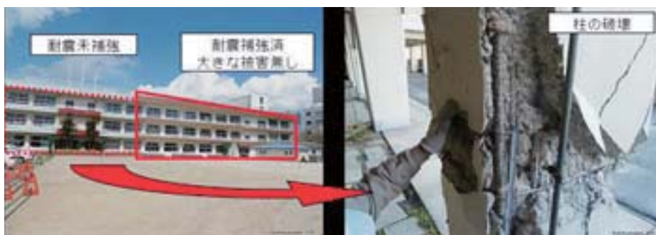
耐震補強済の部分と未補強の部分との被害状況の比較
