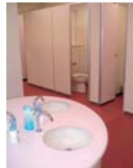
改修後のトイレ (川崎市下作延小学校) 「学校トイレ改善の取組事例集」より
