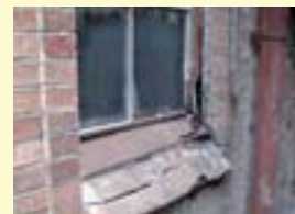
耐震性の不足や外壁落下のおそれのある老朽施設の例
