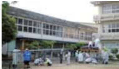
除染作業風景
