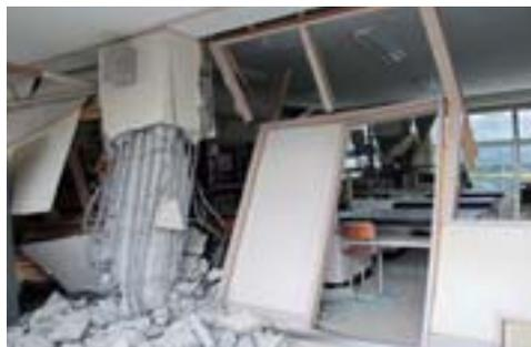
地震により崩壊した教室の柱(福島県福島市)
