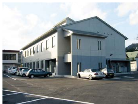
緊急事態対応対策拠点施設(オフサイトセンター) (岡山県鏡野町)
