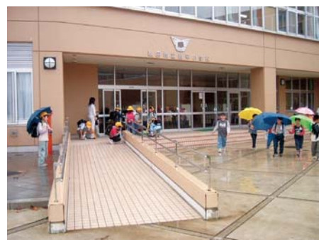
昇降口の段差を解消するため設置したスロープ (秋田県秋田市立勝平小学校)
