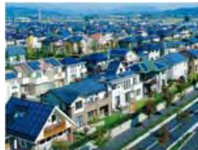
太陽光発電システム実証試験地区 (群馬県太田市P a i T o w n城西の杜) 写真提供：新エネルギー・産業技術総合研究所
