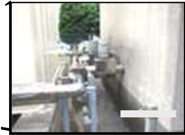
緊急遮断弁を設置した受水槽。 災害時に弁が閉まり、配水管断裂による建物内の漏水を防ぐ。
