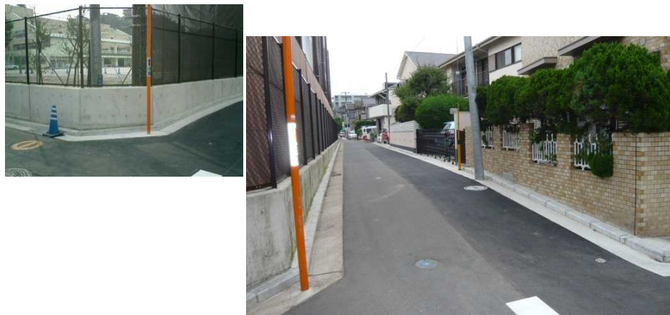
災害時の避難経路として小学校の周辺道路の拡幅・隅切りを実施
