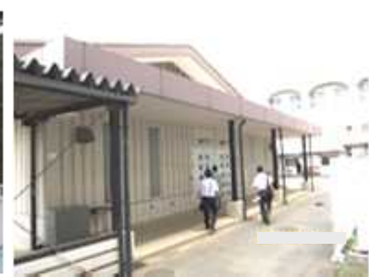
備蓄倉庫(部室の整備に併せて設置した例)
