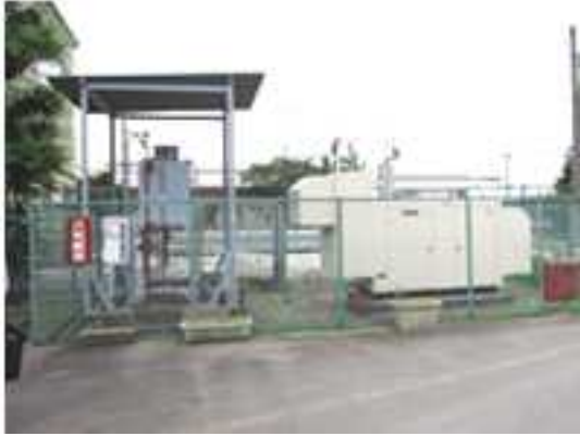
自家発電設備(150kVA)、500Lの燃料小出槽、5,000Lの地下タンク貯蔵所により、48時間分の電源を確保。
