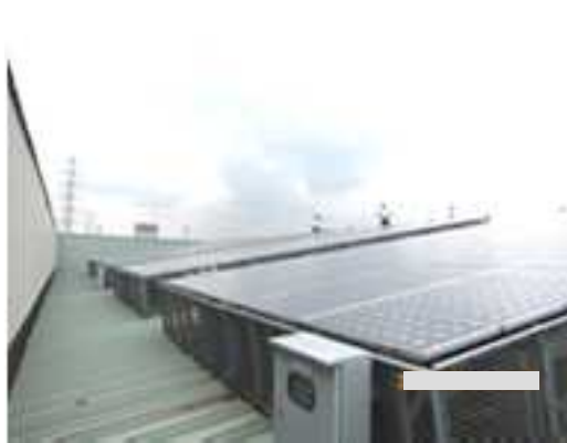
屋上の太陽光発電設備(発電容量30kW)。建物の内外に発電量パネルを掲示。
