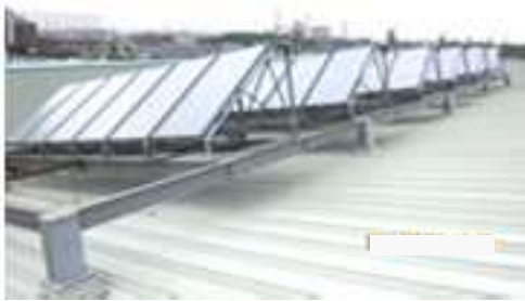
屋上の太陽熱集熱パネル。建物の1階に蓄熱タンク(2,000L)・貯湯槽(4,000L)を配置。
