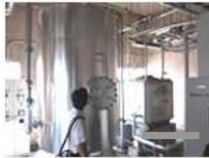
屋上の太陽熱集熱パネル。建物の1階に蓄熱タンク(2,000L)・貯湯槽(4,000L)を配置。
