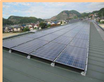
太陽光発電設備
