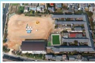
和歌山県高野町立高野口小学校 / 1937
