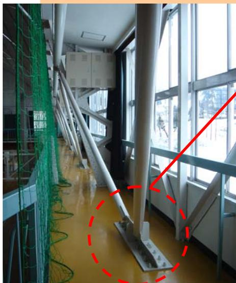
鋼管ブレースのアンカー部
