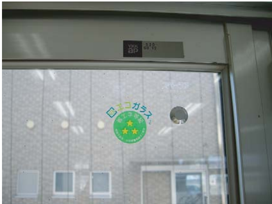
暖冷房機器の入っている職員室、地域連携室の開口部のガラスはすべて真空ガラスへ改修。
