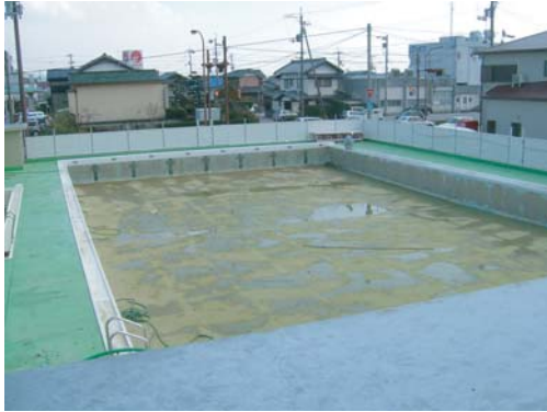
改修前 プール
