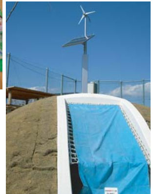
完成したエコステーション
