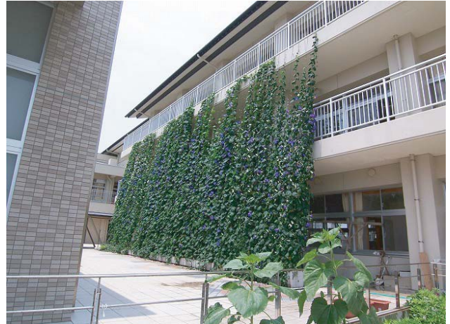
南側には、琉球アサガオによる壁面緑化を設置。
