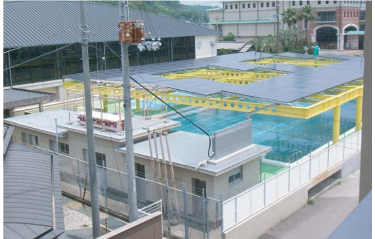
改修後 プール
