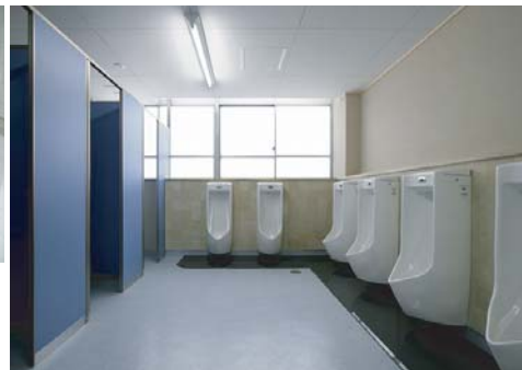
改修後の便所 使用量の少ない便器に更新。
