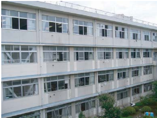
改修前 校舎南側の外観
