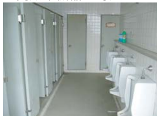
改修前の便所
