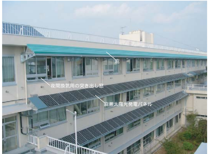
改修後 校舎南側の外観
