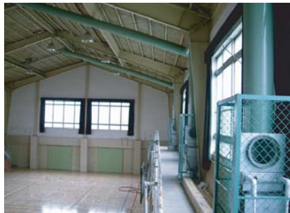
太陽熱利用空気式低温輻射床暖房を体育館に導入。夏期は、太陽熱で体育館の手洗へ給湯も可能。
