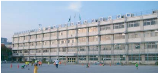
改修前 南側外観
