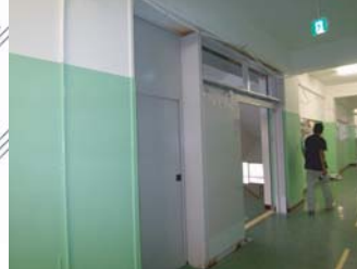
階段室に扉を設置し、冷気を遮断。
