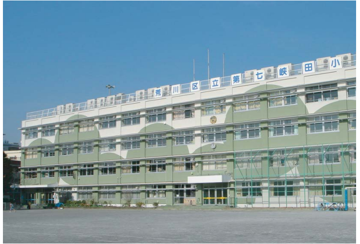
改修後 南側外観
