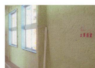
ウレタン吹き付けによる内断熱。
