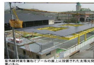
紫外線対策を兼ねてプールの屋上に設置された太陽光発電パネル。
