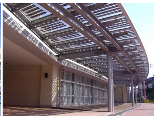
庇を兼ねた太陽光パネルを設置
