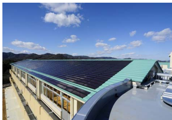
校舎屋根に太陽光パネルを設置
