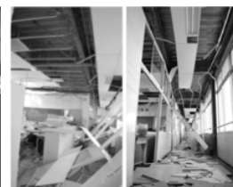
非構造部材の被害
