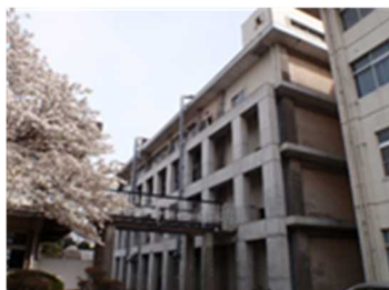
旧薬学部2号館を改修
