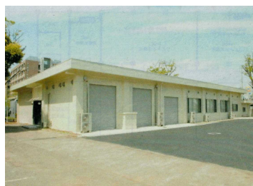
旧エネルギーセンター棟を改修
