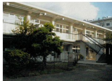
旧薬学部講義棟を改修
