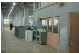
旧エネルギーセンター棟改修前後
