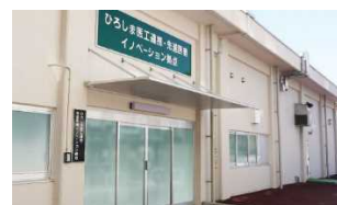
中央設備棟を改修
