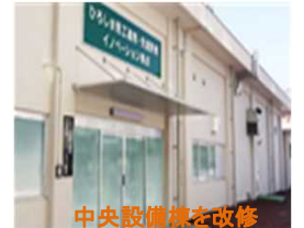
中央設備棟を改修
