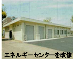
エネルギーセンターを改修
