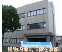
建物内部2,3階を改修
