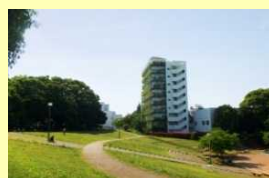
周囲の緑と融合するグリーンウォール（壁面緑化）を設置
