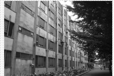
▲老朽施設の外観（経年48年）
