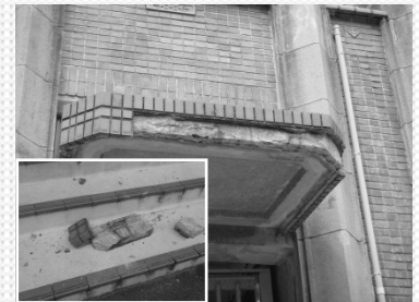
▲外壁タイルの剥落
