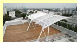
屋上に膜構造実験装置を設置
