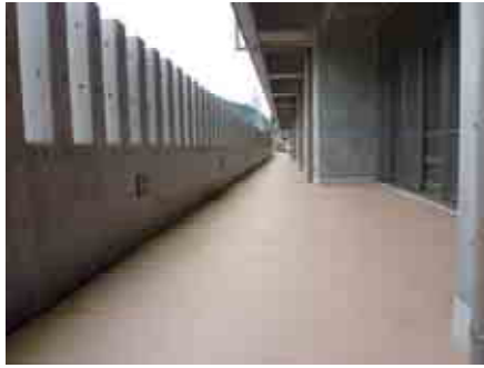
外構舗装等に瓦廃材の利用。 (石川県白山市立白嶺小中学校)
