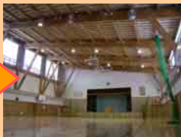
完成した屋内運動場。 地元産カラマツの間伐材を約1500本利用。
