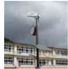
風力発電時計を設置。 (三重県志摩市立浜島小学校)
