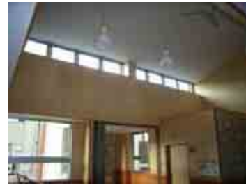
トップライト・ハイサイドライトを利用した採光による 照明負荷の低減。(福井県越前市立南中山小学校)
