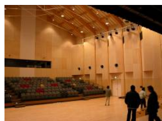
岡山県産材を利用し、講堂内部を木質化。 (岡山県鏡野町立鏡野中学校)
