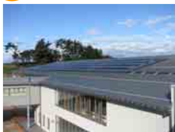
太陽エネルギーにより貯湯し、夏季にはプールのシャワー水として利用。 (福島県二本松市立東和小学校)
