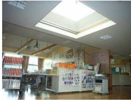
トップライト・ハイサイドライトを利用した採光による 照明負荷の低減。(福井県越前市立南中山小学校)
