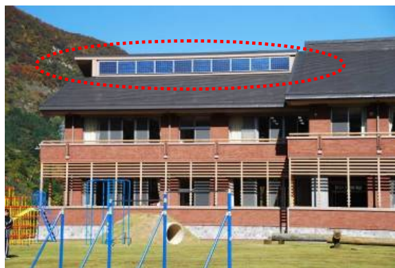
雪害を考慮し、外壁面に2.0kWの太陽光発電パネルを設置。 (石川県白山市立白嶺小中学校)
