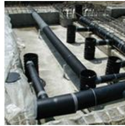
地中熱交換システム用パイプの埋設工事。
