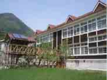
太陽熱利用設備とウッドデッキ
