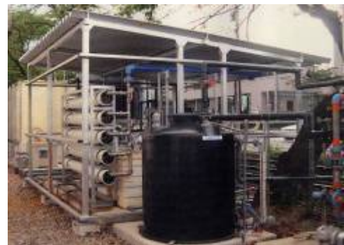
専用水道（井水）システム設置状況
