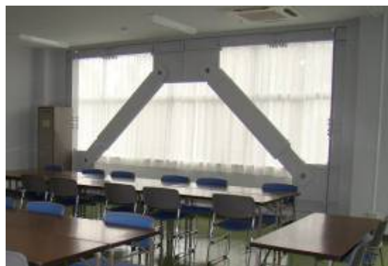
粘弾性ダンパーブレース設置により耐震化完了
