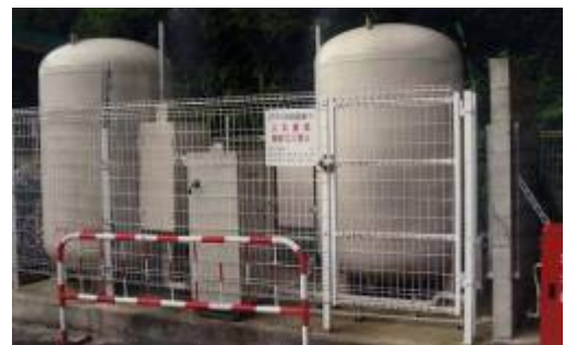
災害対応バルクタンク設置状況
