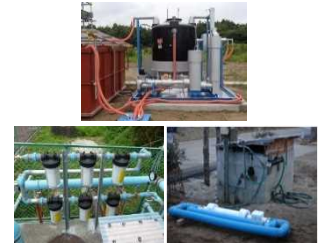
富岡道路工事現場(上)、プール(左)、井戸水(右)での安全安心確保
